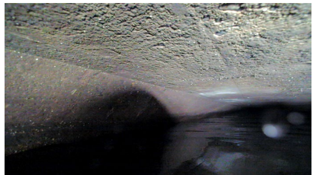
水位の高い管奥にも進入して撮影を行った
