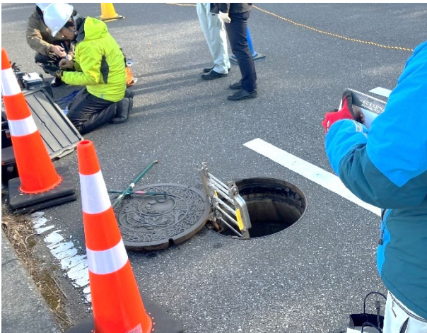
水陸両用走行型ドローンを投入/回収したマンホール
