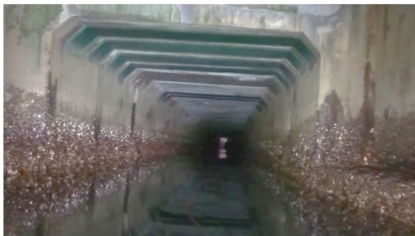
雨水管内を進む水陸両用走行型ドローンのFPV画像
